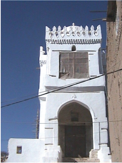
البوابة الشرقية بعد أعمال الترميم وإعادة القضااض
